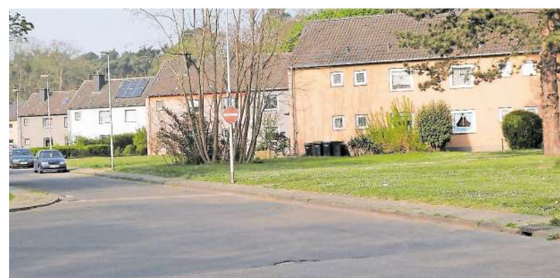
So sehen die Straßen heute aus, ausreichend Platz für Autos, aber schmale Bürgersteige. Eine Mischfläche wäre eine Möglichkeit, die Situation zu verbessern.
